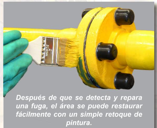
*Después de que se detecta y repara una fuga, el área se puede restaurar fácilmente con un simple retoque de pintura.*
