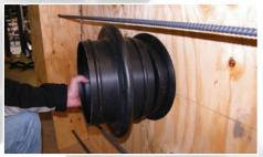
3. Corta la manga Infinity $^{\otimes}$   $^{3}4$ " más corta que el espesor de la pared (+/-1/4"), y luego insertala en la tapa que abas de fijar.
