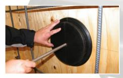
1. Coloca la varilla através del molde y la primer tapa. Coloca una tuerca afuera del molde.
