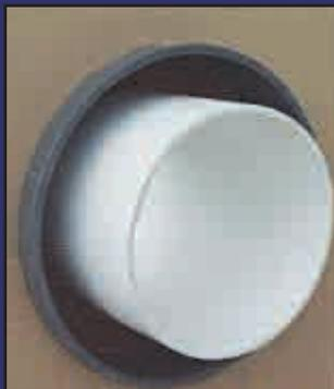
1. Centrez le tuyau, le câble ou le conduit dans le manchon mural, le boîtier ou le trou percé. Assurez-vous que le tuyau sera correctement soutenu aux deux extrémités. Les Innerlynx® ne sont pas destinés à supporter le poids du tuyau.
